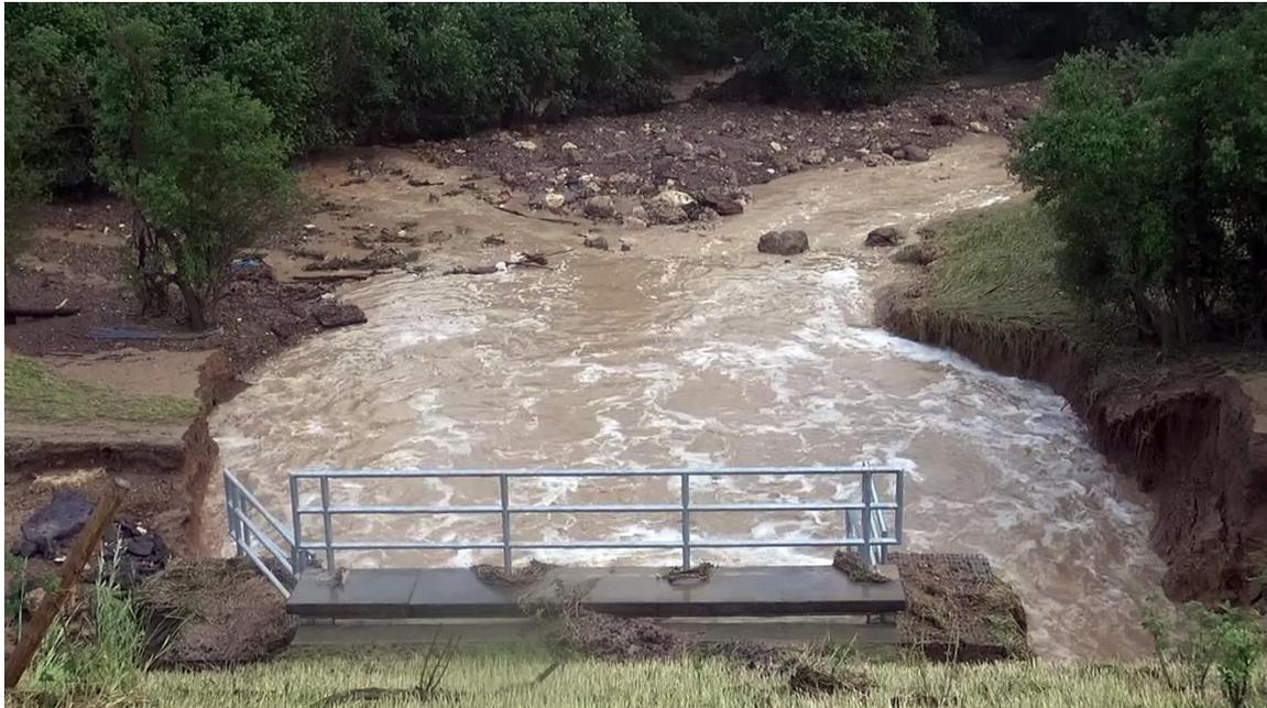
**Abbildung 8: Überströmtes Regenrückhaltebecken bei Nierendorf (Copyright: SWR)**
