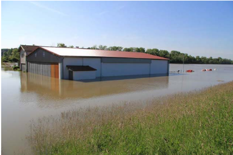
Abb. 9: Überschwemmtes Segelfluggelände in Oppenheim nach Überströmen des Sommerdeichs. (Foto: Ehler Fell)
