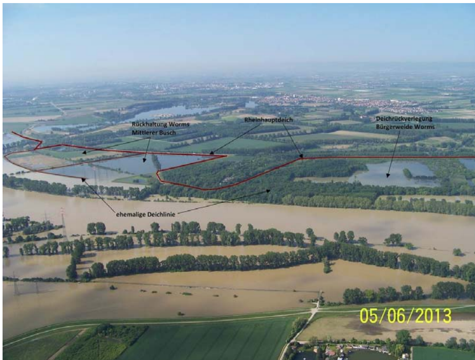
Abb. 14: Eingestaute Hochwasserrückhaltungen Worms Mittlerer Busch und Worms Bürgerweide (Foto: Wasserwirtschaftsverwaltung Rheinland-Pfalz)
