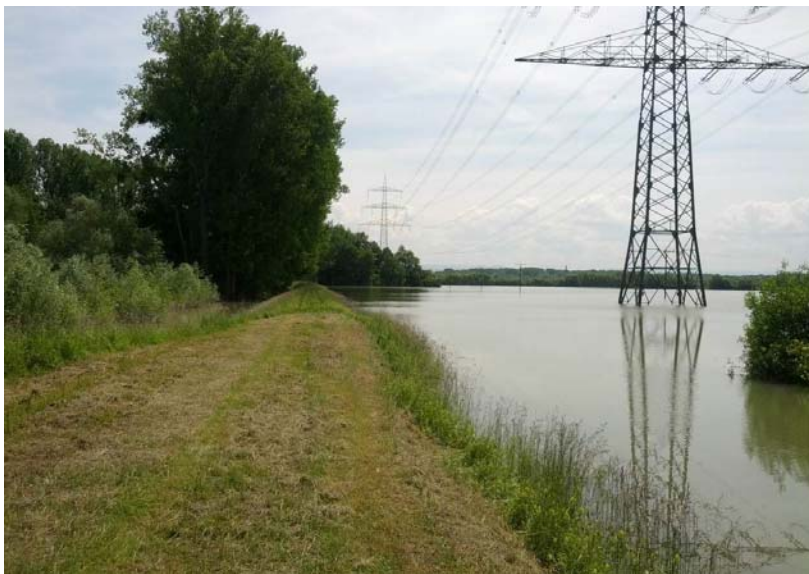
Abb. 13: Eingestaute Hochwasserrückhaltung Daxlander Au (Foto: Wasserwirtschaftsverwaltung Rheinland-Pfalz)
